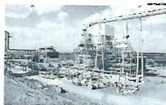
INDUSTRIA ainda na fase de construção
