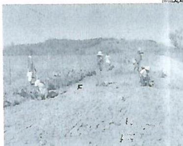
Estrada que liga ao Sapé está sendo pavimentada
