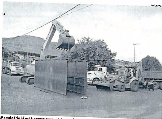
Maquinário já está pronto para iniciar as obras
