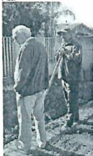
PREFEITO Reinaldo Cardoso visita obras pessoalmente
