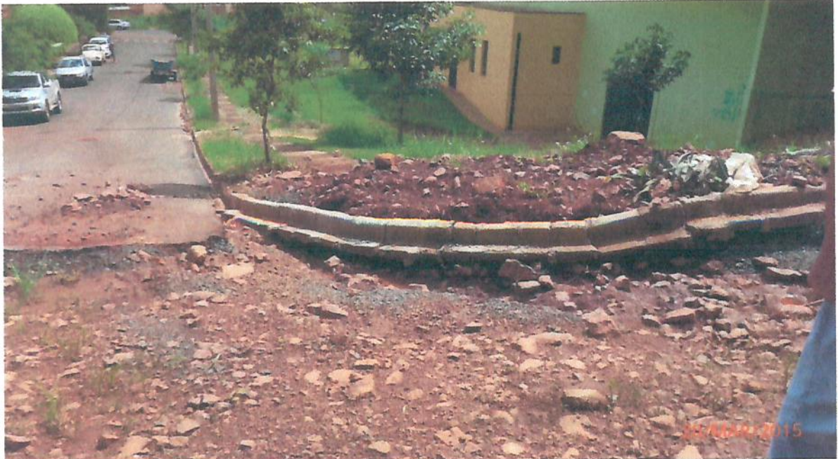
Foto4, conforme mostra à foto, a enxurrada está estragando o meio fio com sarjeta executado.
